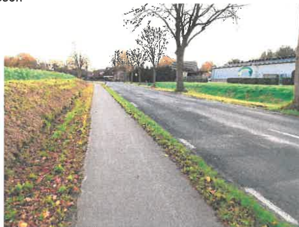
Links Geländekante und Plangebiet, rechts Wilholter Straße und GE Willesch
