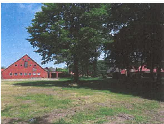
[9] Stall- und Wirtschaftsgebäude Nordostbereich
