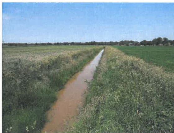
[2] Westl. Renkenberge; Graben
