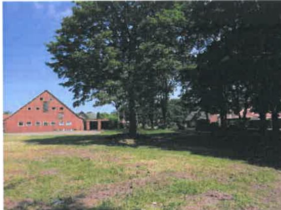
[9] Stall- und Wirtschaftsgebäude Nordostbereich
